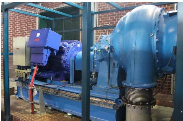
Bild 8: Neuer Turboverdichter (42.000 Nm<sup>3</sup>/h, 630 mbar, 950 kW), noch ohne Schallhaube
