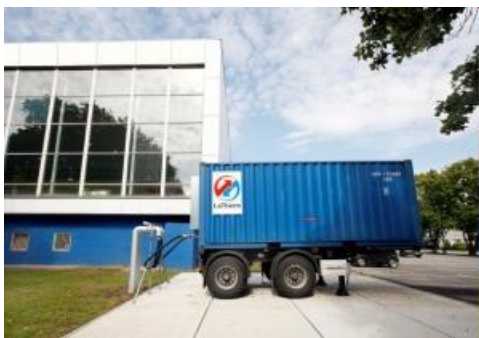
Bild 4: Latentwärmespeicher in Containerbauweise
