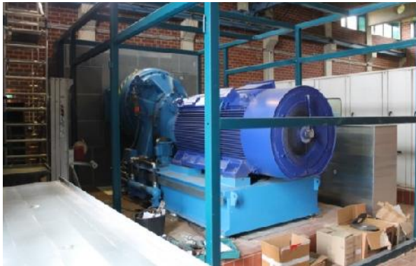
Turboverdichter 42.000 Nm 3 /h, 950 kW
